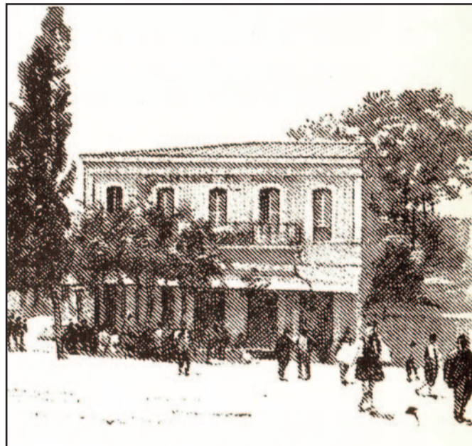
Στο ισόγειο του αρχοντικού Χατζηχρήστου (Σκληθωνιάτου 2) λειτούργησε καφενείο (1897) [φωτ. Henri Turot]
