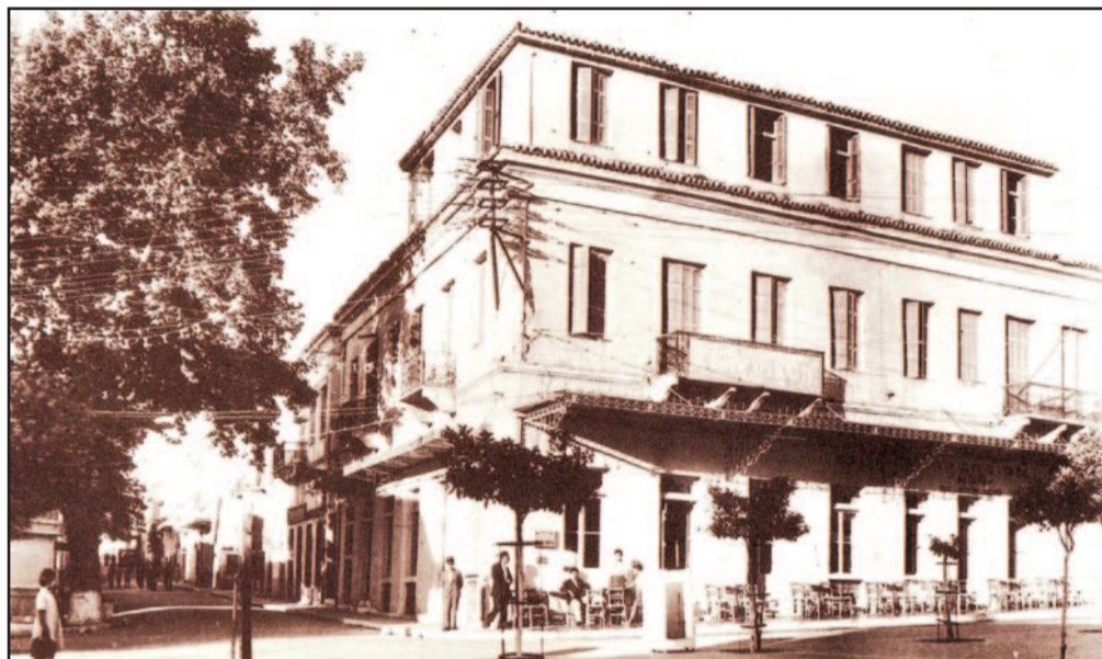
Όλο το ισόγειο του κτιρίου αυτού ήταν το καφενείο Περ. Λεβαδίτου, στην αρχή της οδού Διάκου στην πλατεία Ελευθερίας. Απέναντι ο αιωνόβιος πλάτανος.
